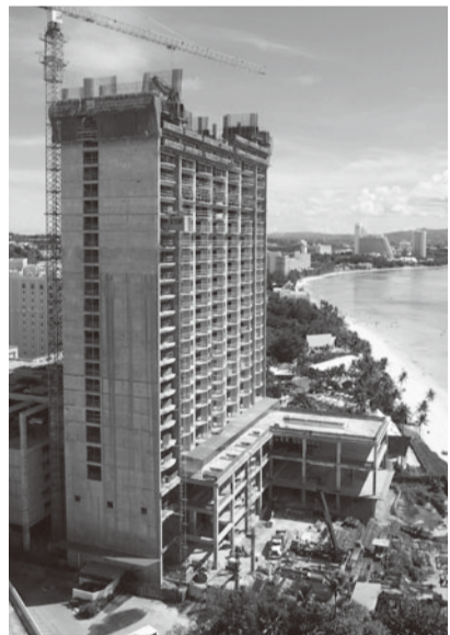
来年のオープンへ向け、急ピッチで建設工事が進む
