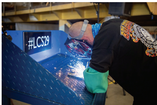
造船の伝統に基づき、フリーダム級LCS「ベロイト」のキールプレートにシッpsポンサーのイニシャルを刻んだプレートを溶接する(提供:ロッキード・マーティン)
